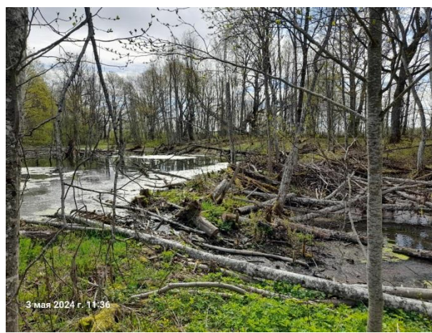
Рисунок I-4.6– Река Велькота (д. Велькота). Бобровая плотина, захламление русла древесиной
