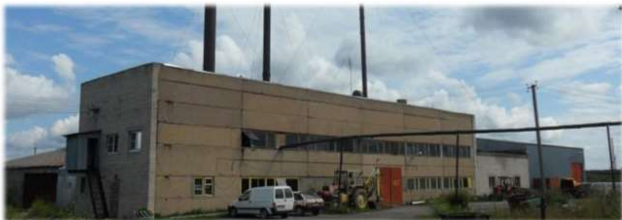
Рисунок 1.2.1.1 Котельная п. Петровское
