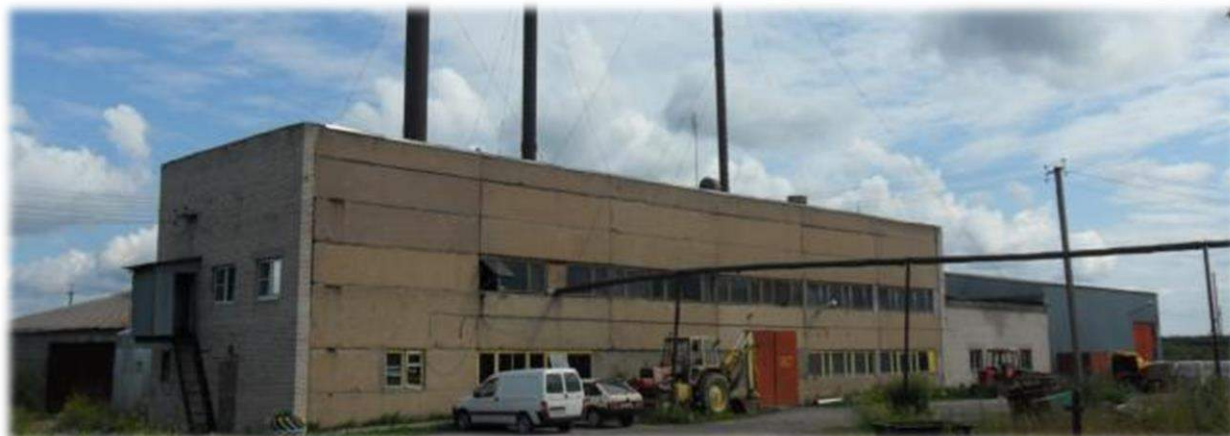
Рисунок 2.1.2.1 Котельная п. Петровское
