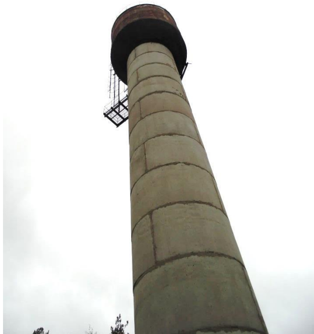
Рисунок 5.2.1.4. Водонапорная башня п. Петровское
