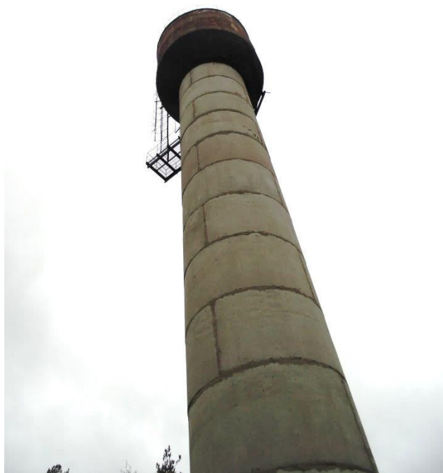
Рисунок 5. Водонапорная башня п. Петровское
