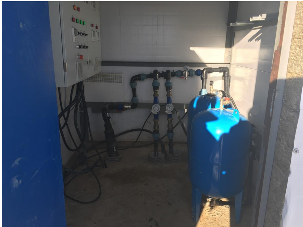
Фото 13. Помещение, в котором находятся скважины ООО «ОМХ».
